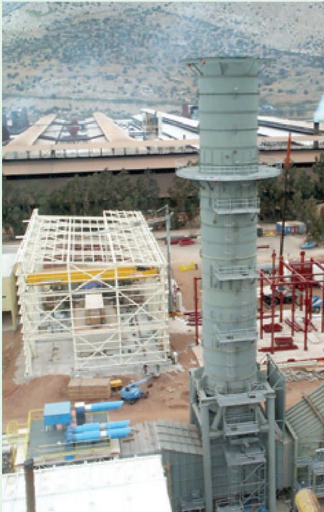
*Gas-turbine exhaust waste heat discharge flue*
